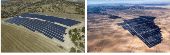
Şekil 1.2 Güneş enerjisi santralleri (fotovoltaik)
